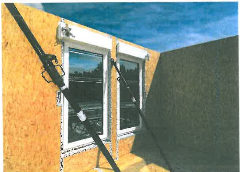
► Die Wandelemente der neuen Etage stehen auf einem Tragrost aus Stahl
